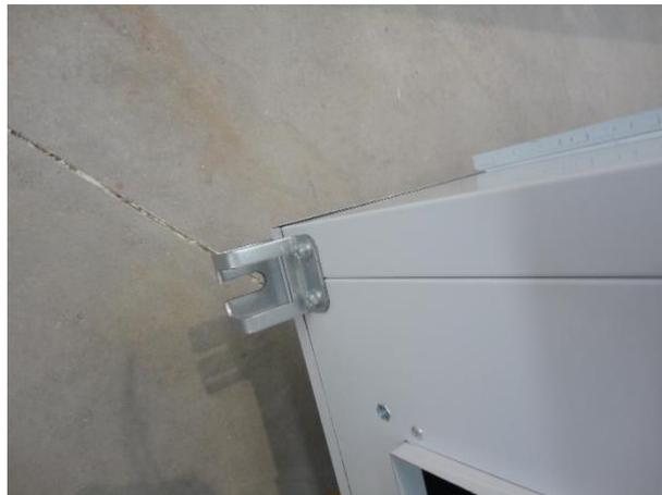
***Lors de l'installation au plafond, il est recommandé de retirer l'échangeur de chaleur de l'unité afin de réduire le poids lors du levage.***
