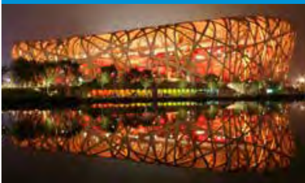
Stade National Beijing. Stades Olympiques
